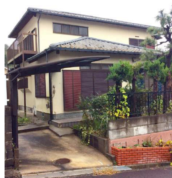
外観ガレージ側
